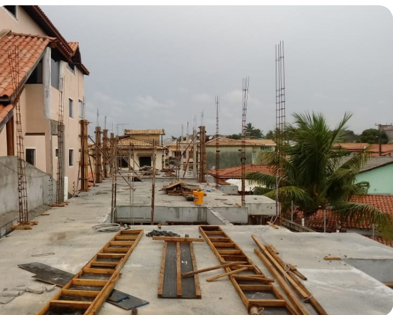
Em construção, a Pousada dos Metalúrgicos é um dos marcos de 2018 para a categoria
